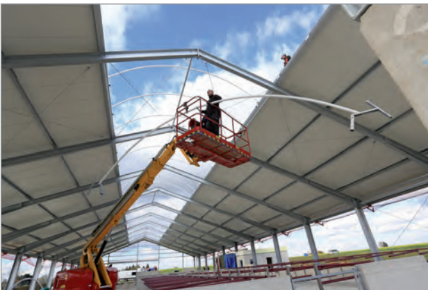
Montage der Bügel an der Dachkonstruktion
