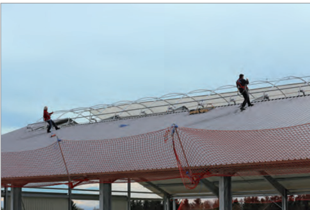
Plane über die Konstruktion ziehen
