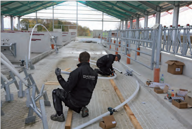
Vormontage der Bügel am Boden
